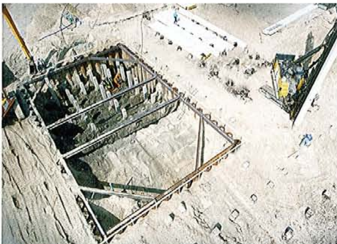
Bild 3. In dem tiefgelegten Bauteil werden die bereits eingebauten Pfähle freigelegt
