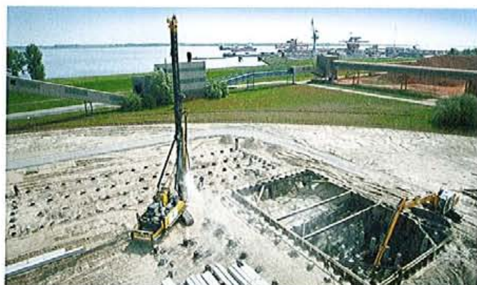
Bild 1. Die Baustelle der Halle zur Rotorblattfertigung von Offshore-Windrädern aus der Luft – mit Elbblick
