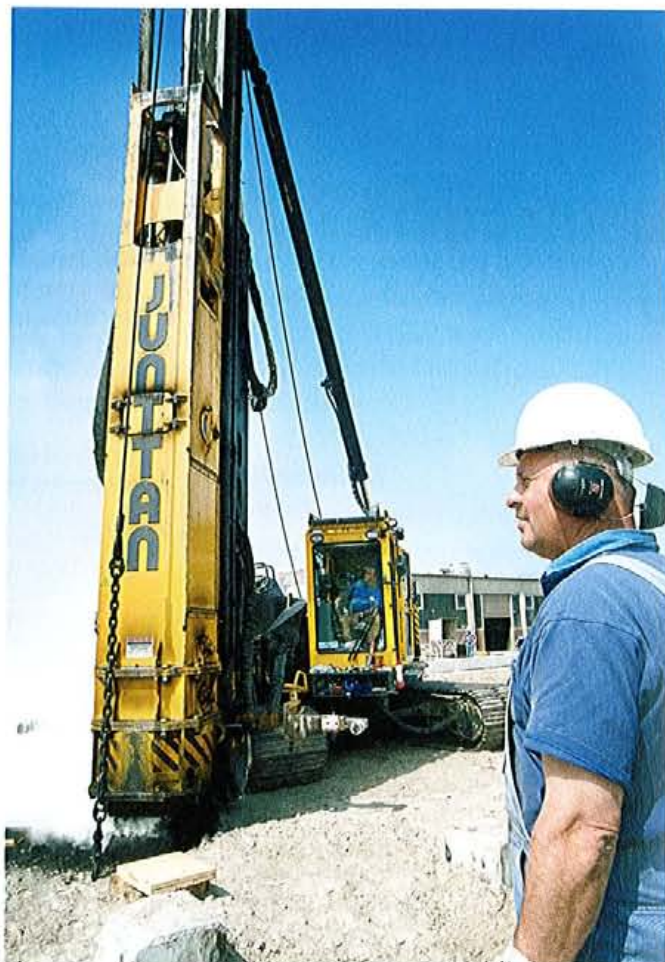
Bild 2. Im Einsatz: Das Rammgerät Junttan PM 20 mit einem 6-t-Rammbar
