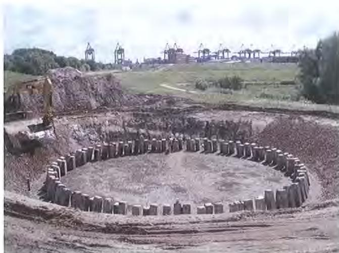
Unter dem Kreisfundament der zwei Windenergieanlagen in Hamburg Altenwerder sind 102 Stahlbetonfertigteilepfähle, System Centrum, gleichmäßig auf zwei Ringen in Radien angeordnet
