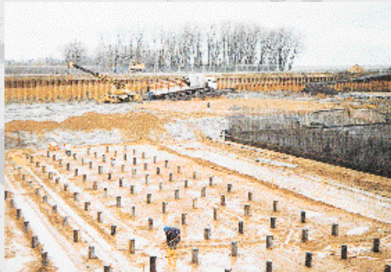
Auftriebssicherung Belebungsbecken
