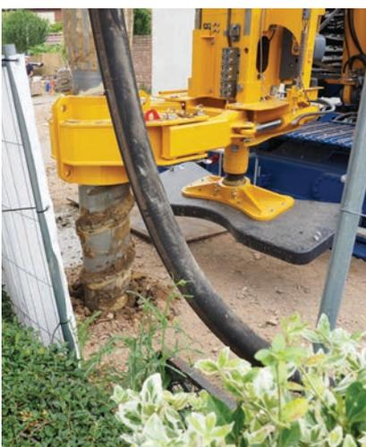
Die BG 28 H ist ein Großdrehbohrgerät und wird vorerst mit einem Bohrwerkzeug für Vollverdrängungsbohrpfähle mit verloraener Spitze mit einem Durchmesser von 440 mm ausgerüstet. Daraus resultiert auch der neue Pfahname. Aarsleff Grundbau hat den neuen Pfahl AG 440 getauft: AG steht für Aarsleff Grundbau und 440 für den Durchmesser.
